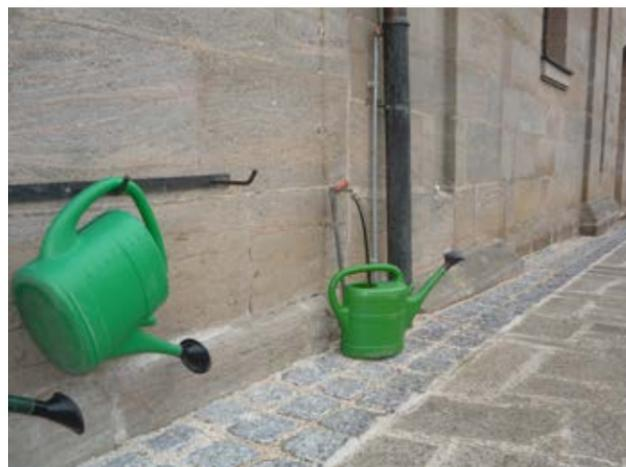
Zwischen Nordmauer und Weg sind die Steine mit Splitt verfugt, damit Feuchtigkeit aus dem Boden kann.
