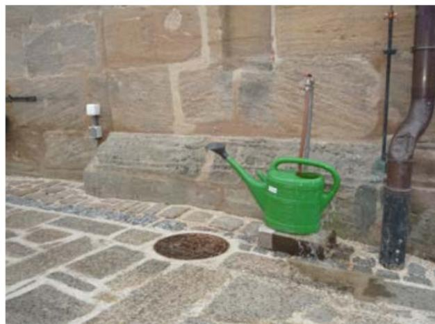
So sollte es nicht sein. Überlaufende Gießkannen führen zu Schäden an der Grundmauer der Kirche.
