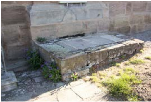
Unterbau der Pfarrersgruft vor der Renovierung
