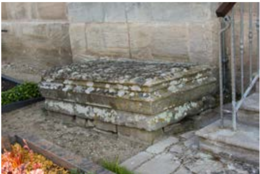
Richtersgruft vor der Renovierung
